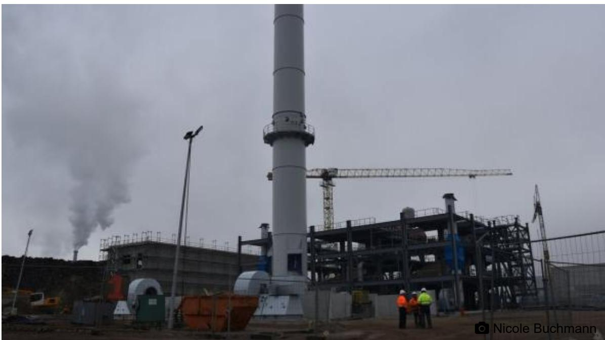
Steht auf mehr als 500 Pfählen: das Biomasseheizkraftwerk im Holzcluster.
