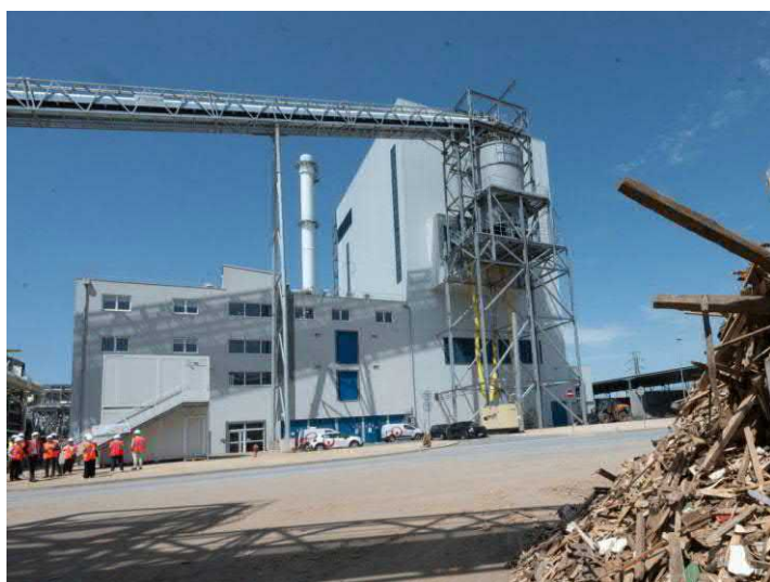
La chaudière biomasse de Green Valley Énergie est alimentée par 5 000 tonnes de bois déclassé par semaine. Photo Eric Thiébaud
